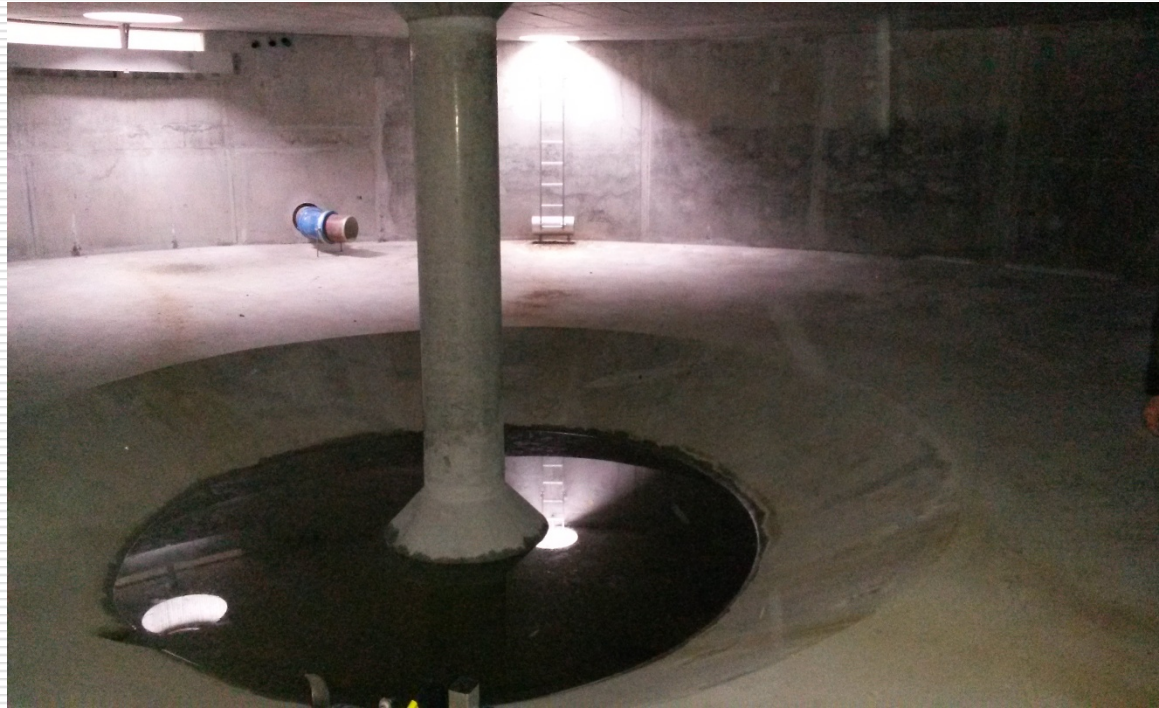
Regenrückhaltebecken Kinzigheimer Weg (ehem. Kläranlage)
