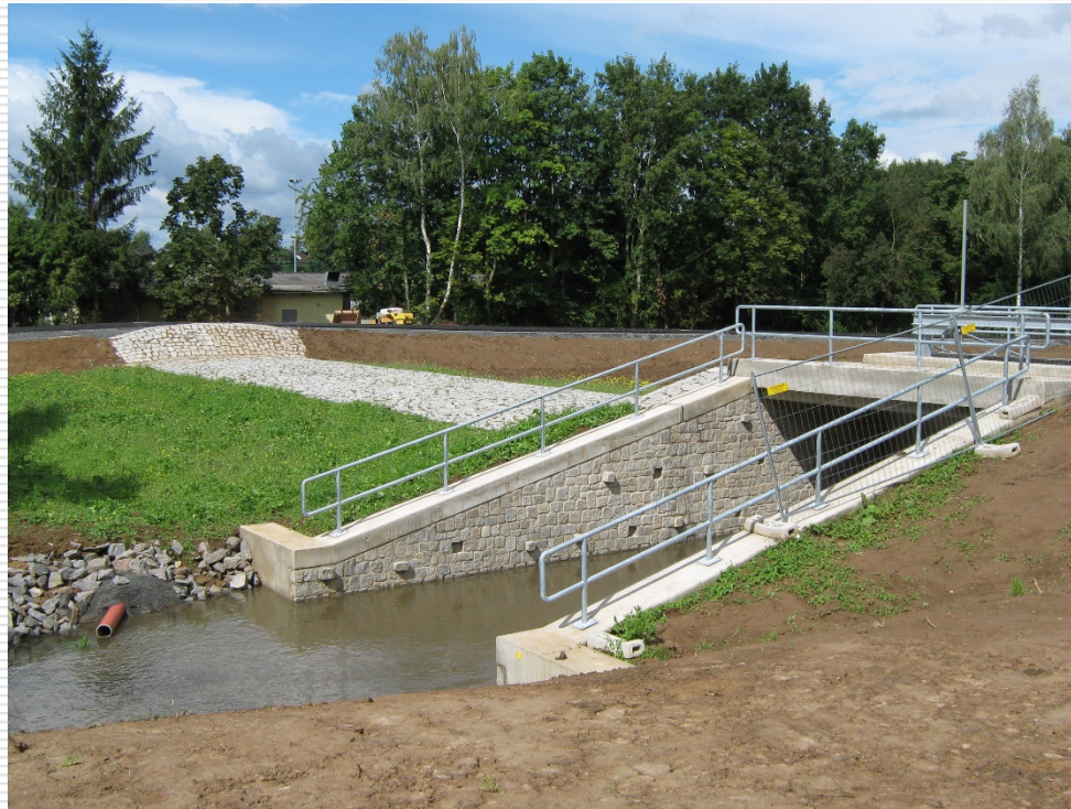
Retentionsraum „Nieder- Oberissigheim“
