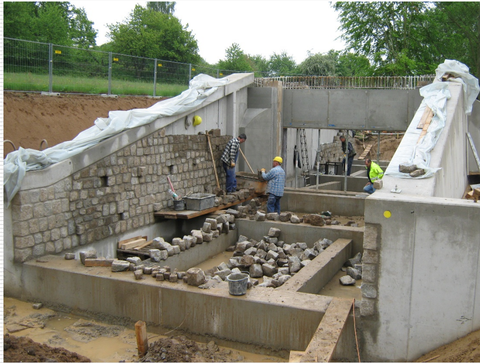
Retentionsraum „Nieder- Oberissigheim“
