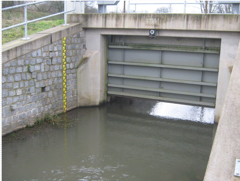
Retentionsraum „Nieder- Oberissigheim“
