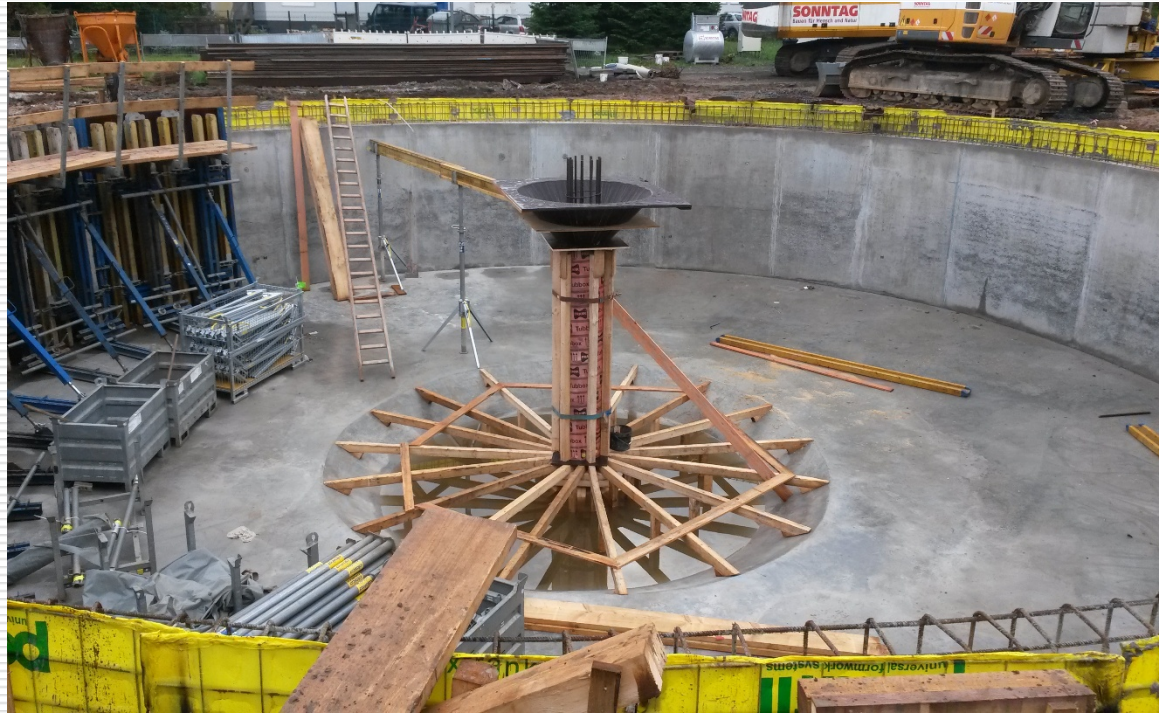
Regenrückhaltebecken Kinzigheimer Weg (ehem. Kläranlage)
