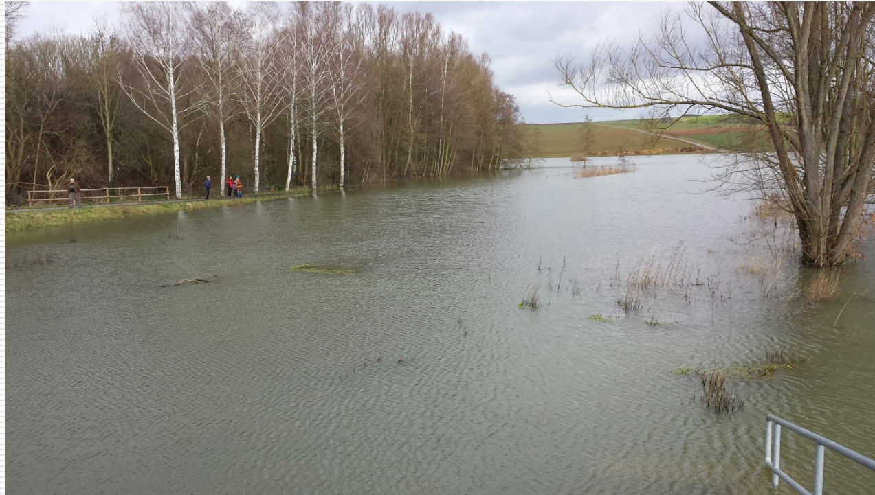
Retentionsraum „Nieder- Oberissigheim“
