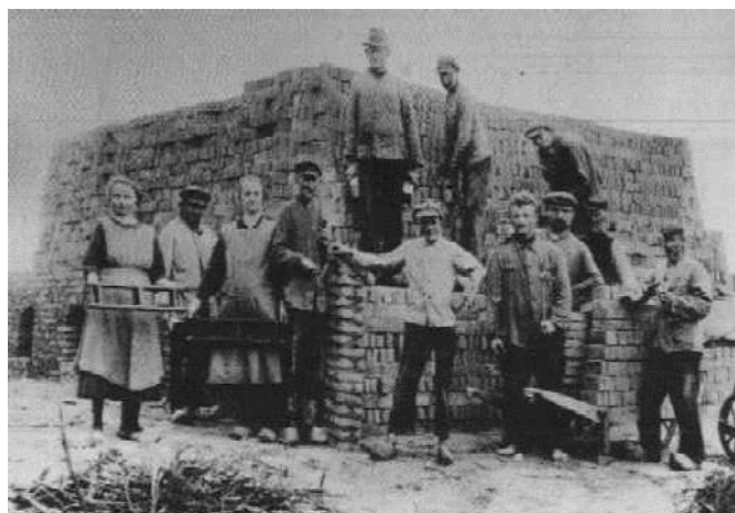
Setzen eines Feldbrandofens um 1927, Quelle: W. Leinemann, Handwerkliche und industrielle Ziegeleiherstellung
